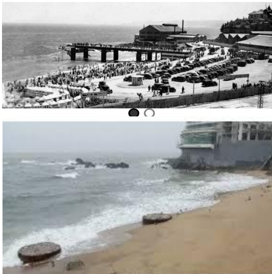
Figura 32. Imagen de playa Caleta Abarca, antes con muelle proyectándose hacia el mar. Ahora, después del temporal del 8 de agosto de 2015, quedan a la vista los cimientos de las columnas de antiguo muelle.
