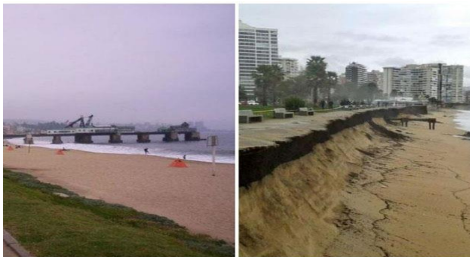
Figura 30. Imagen socavamiento sector playa Acapulco, donde se encontraban los módulos y puestos de feria artesanal.
