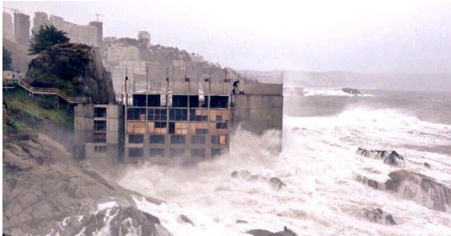
Figura 29. Imagen de construcción de Hotel Punta Piqueros siendo afectado por evento de Marejadas.
