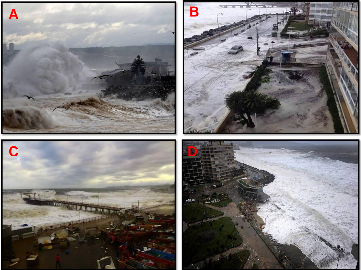
Figura 8. (A) Valparaíso: Marejada azotando sector El Caleuche y daños en vía férrea (theclinic.cl, 08/08/2015), (B) Viña del Mar: Daños sector Avenida Perú (puranoticia.cl, 08/08/2015), (C) Valparaíso: Daños muelle Caleta Portales (soychile.cl, 08/08/2015), (D) Viña del Mar: Sobrepasso y daños restaurant Tierra de Fuego, sector Playa Acapulco (elepicentro.cl, 08/08/2015)
